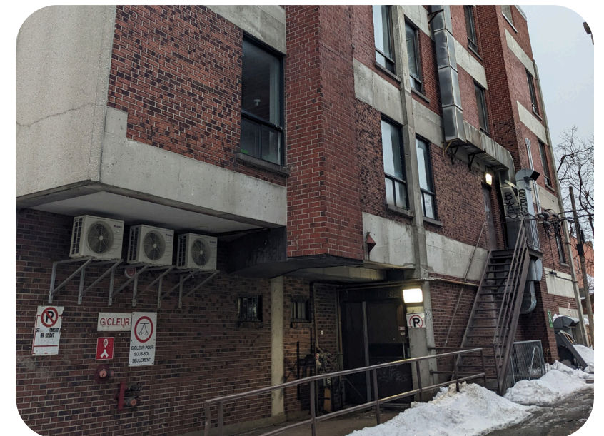
Façade ruelle côté Durocher
